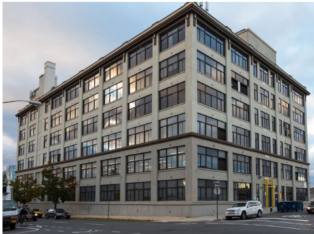
مبنى سبيس ووركس نموذج لمكتب في المنطقة التجارية الصناعية في لونغ آيلاند سيتي
