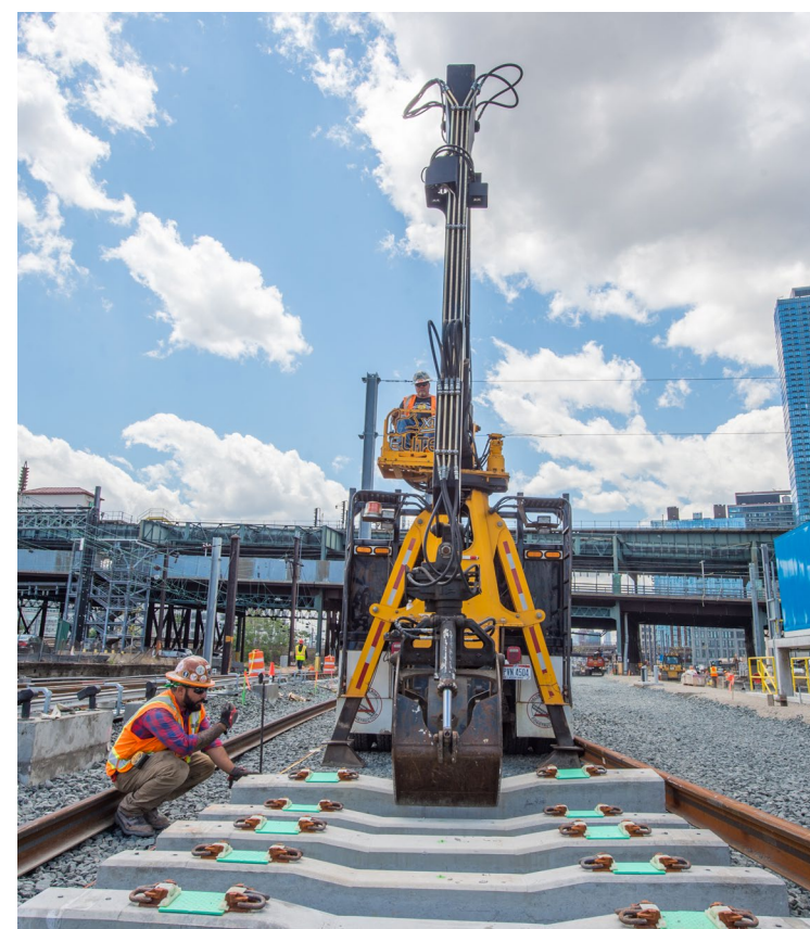
MTA的日间存放站场（建设中）
